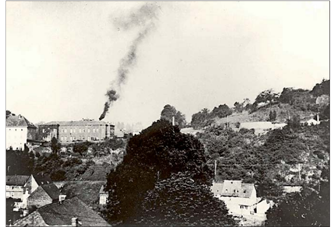
Foto der Anstalt Hadamar mit rauchendem Schlot.
