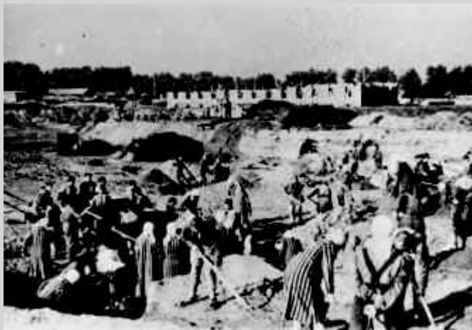
Erdarbeiten in der Nähe von Blachownia / Blechstadt bei Częstochowa / Tschenstochau, 1942 (AFPNP)
